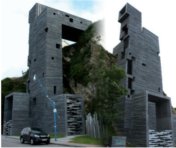
10 Elizabeth Abalo Díaz y Gonzalo Alonso Núñez, Ascensor panorámico, Ribadeo (Lugo, 2010). Fotografía de la obra terminada (arriba) y modelo analítico tridimensional (abajo).
