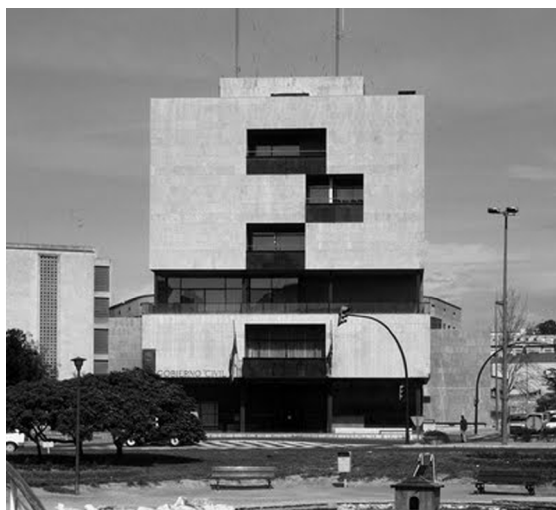
01 Alejandro de la Sota, Gobierno Civil de Tarragona; fachada principal.
