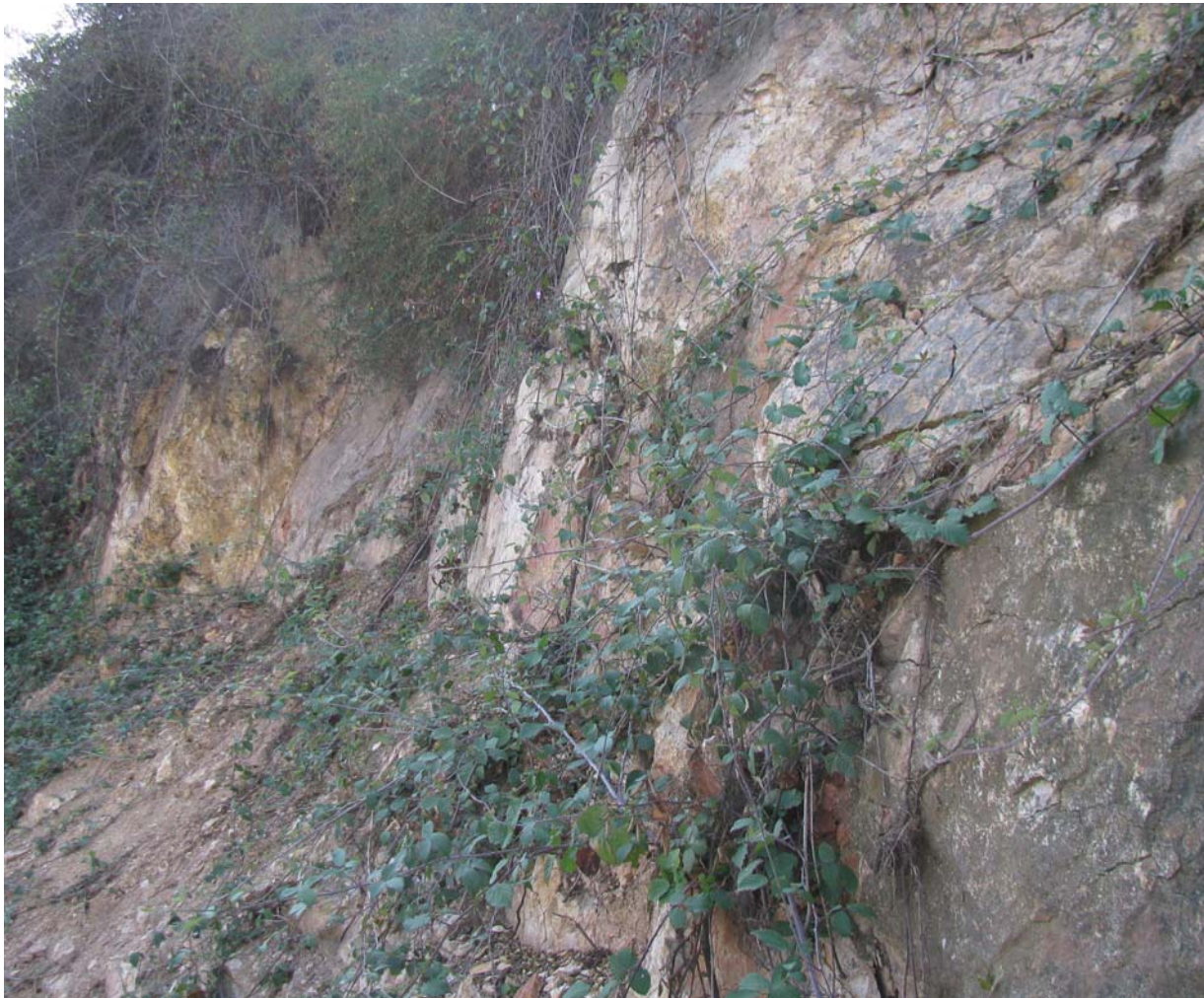
Fig. 2. Maciços muito alterados com descontinuidades que podem afetar o comportamento dos mesmos em termos de movimentos de massas (notar também a relação entre as descontinuidades e as raízes de árvores).
