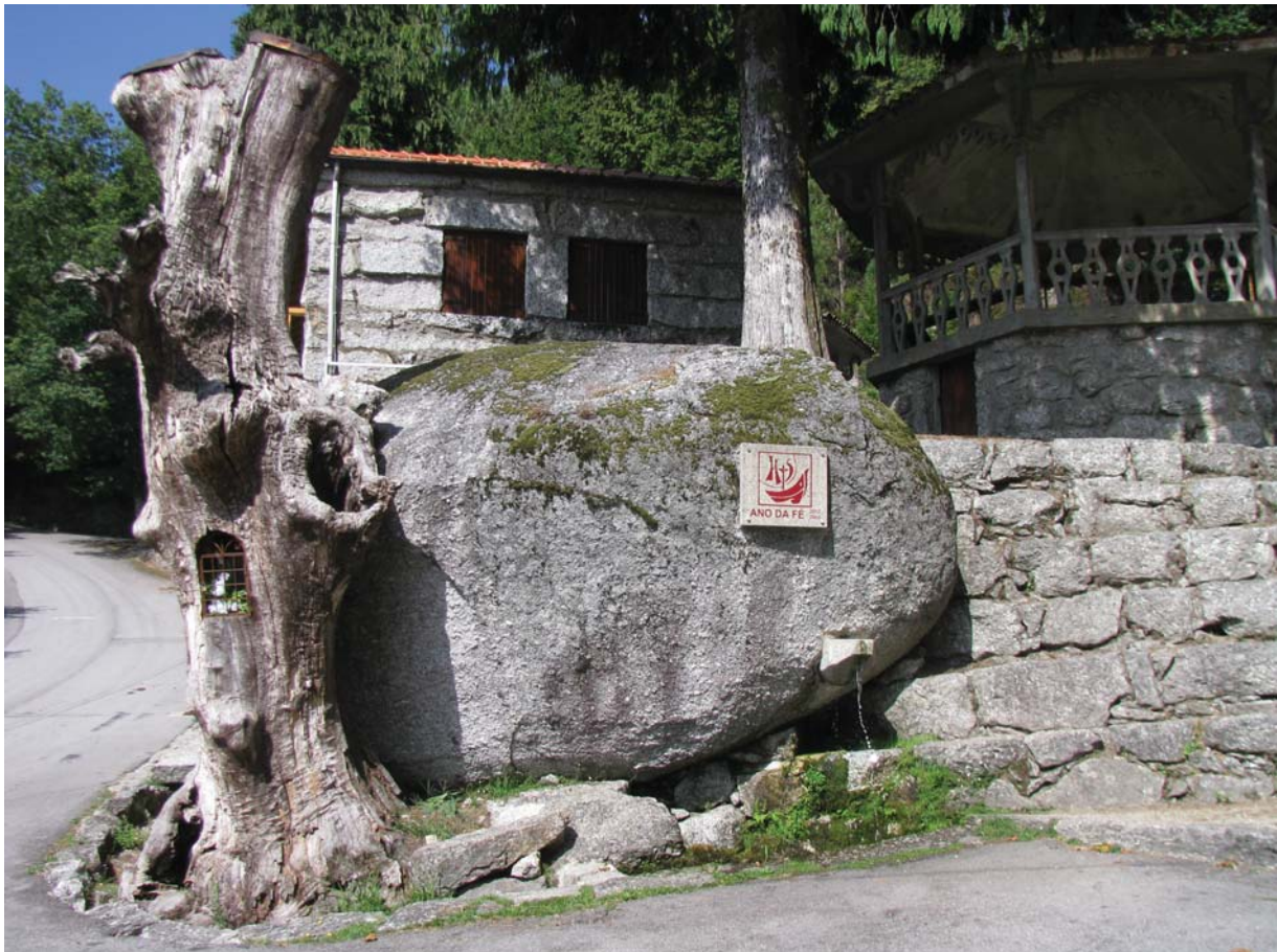
Fig. 4. Incorporação no ambiente construído de bloco granítico com nascente de água.
