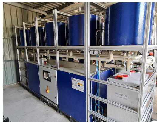
Figura 1: Planta piloto de destilación por membranas en IFAPA.
