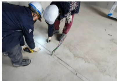
Figura 1: Proceso manual de verificación dimensional previo al montaje (Park, E. et al., 2022).
