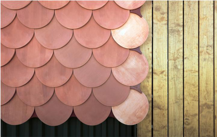
Fig. 12. Detalle de los dos sistemas de la envolvente de la nave principal de Santa Genoveva: teja cerámica escamada a medida y madera de pino acetilada.
