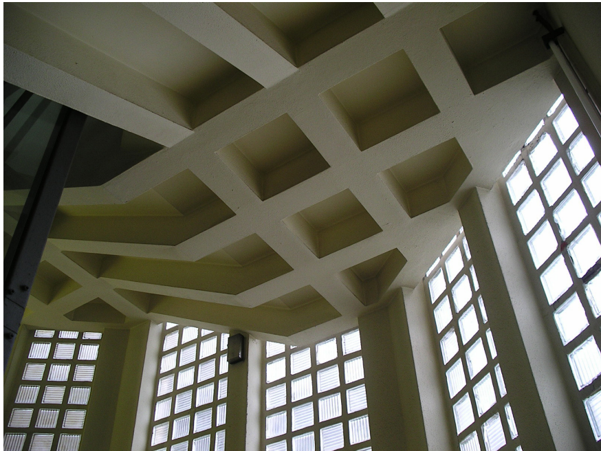
Figura 7. Escuela de Magisterio: escalera principal.
