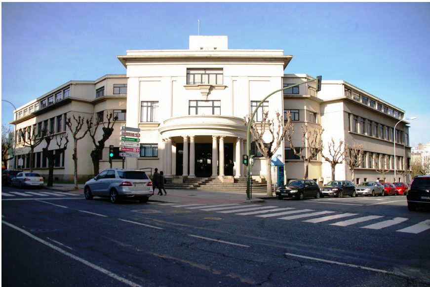
Figura 12. Escuela de Comercio. Vista general desde el sureste.
