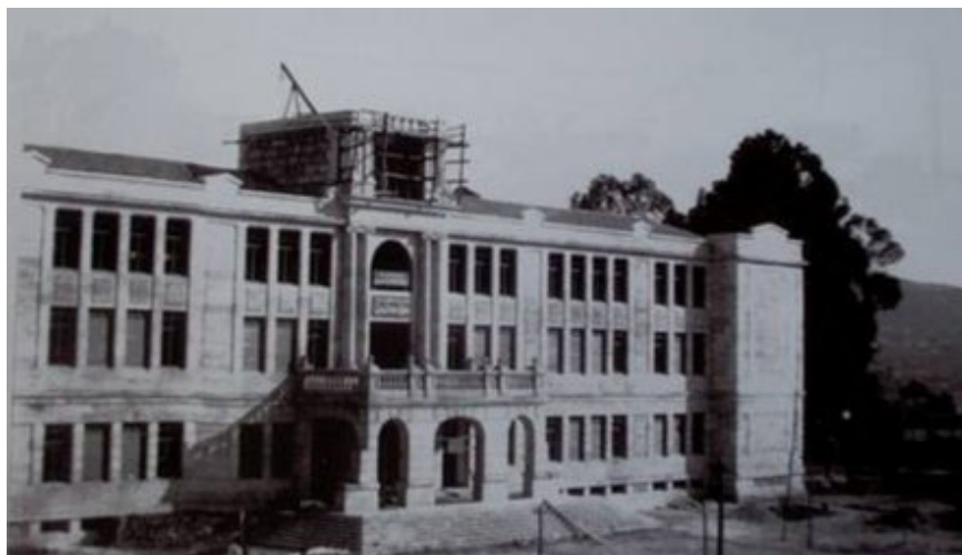
El instituto en construcción 49 .
